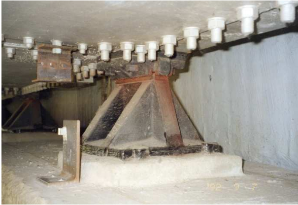
Abb. 47 Festlager, Bauwerk 13 alt Potsdam
