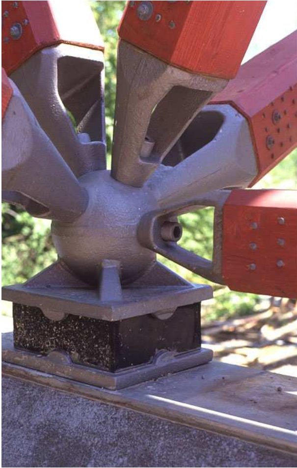
Abb. 45 Auflager Meroknoten, Thalkirchener Brücke München
