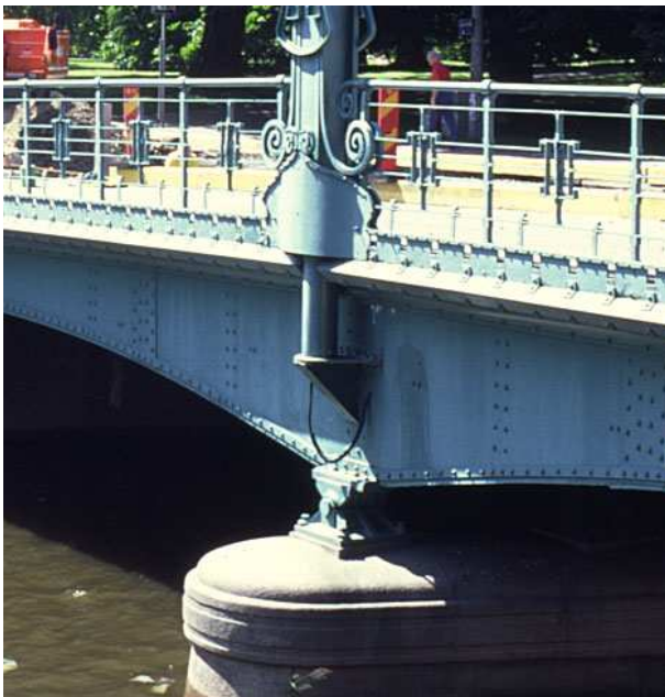
Abb. 41 Rollenaufleger in Brückenmitte, Eisenbrücke in Göteborg
