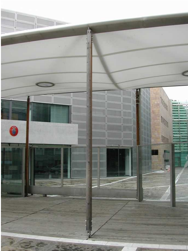
Abb. 50 Pendelstütze aus Holz
