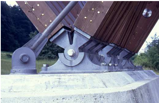
Abb. 44 Festauflager-Zwischenstützen, Essingen
