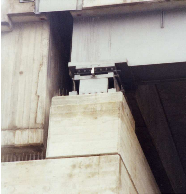
Abb. 40 Verschiebliches Auflager, Zufahrt zum Flughafen Köln
