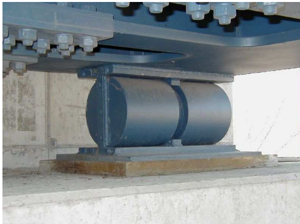
Abb. 39 Rollenlager - verschiebliches Auflager, Bauwerk 13 alt Potsdam
